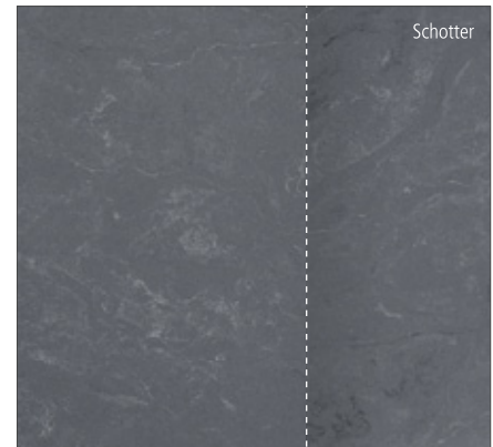
Farbunterschiede im Plattenstoß
